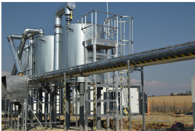
Vďaka tomuto zariadeniu sa 750 Nm 3 /h bioplynu upravuje na biometán. V budúcnosti sa má spracovávať až 1 300 Nm 3 /h. (Foto: EnviTec Biogas AG)
