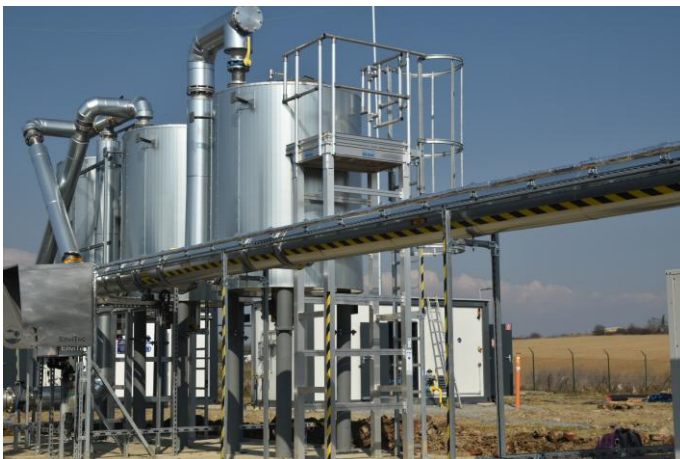
Díky tomuto zařízení se 750 Nm 3 /h bioplynu upravuje na biometan. V budoucnu se má zpracovávat až 1 300 Nm 3 /h. (Foto: EnviTec Biogas AG)
