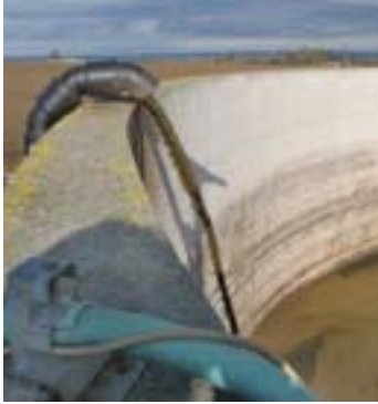
Die Substratreste werden nach der Vergärung in einer offenen Lagune gelagert.
